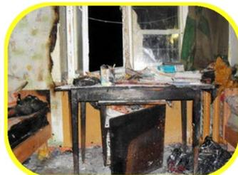
Нельзя применять различные самодельные электрические обогревательные устройства. При использовании ими электрическая сеть подвергается длительной значительной перегрузке, что очень часто приводит к воспламенению изоляции электропроводки и пожарам.
